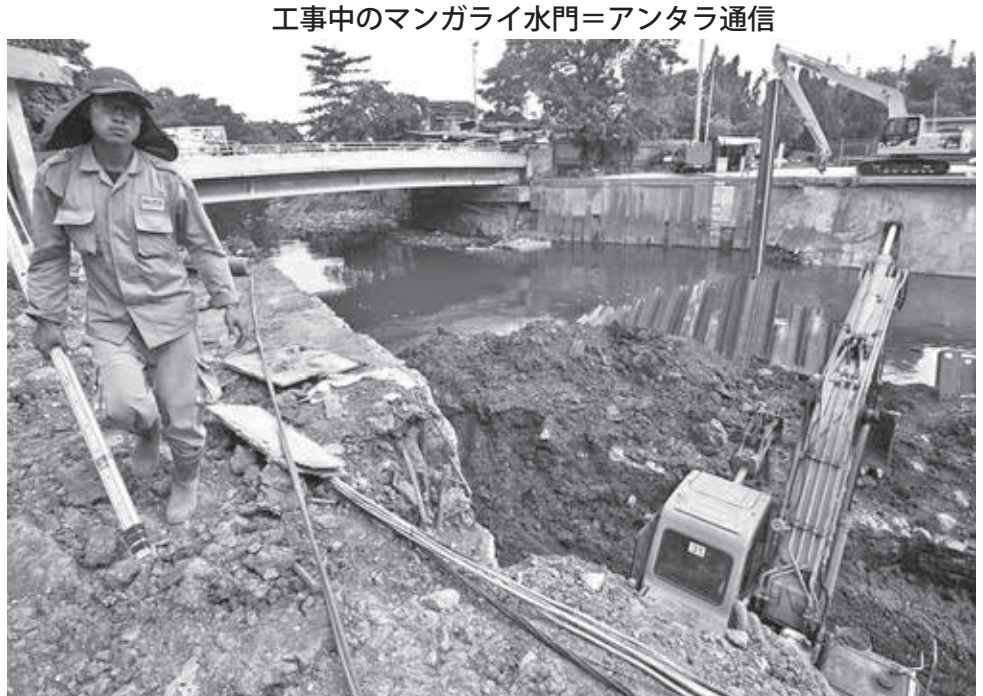
工事中のマンガラ水門=アンタラ通信
